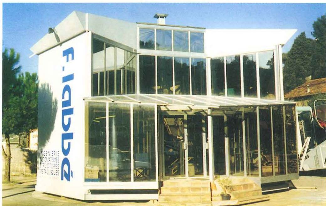
▲ Les bureaux de la métallerie F. Labbé sont installés dans une de leur invention : une maison à structure métallique qui peut tourner à 360°
