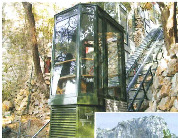
▲ Ascenseur incliné implanté sur la presqu'île de Saint-Jean-Cap-Ferrat
